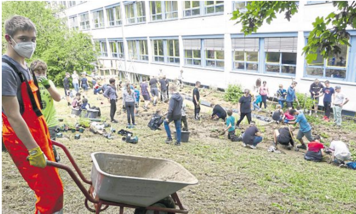
Drei Tage lang bearbeiteten die Mädchen und Jungen trotz Regens mit Begeisterung die große Kuhle für das Biotop mit Pickel und Schippen. Dann brachten sie die Teichfolie und Wasser ein und setzten die Wasserpflanzen in Kies.
